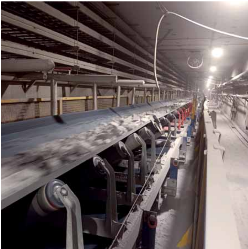
❖ Recientemente, en Caserones se reemplazó la cinta transportadora en el área del chancador primario, tras cumplir su vida útil.
